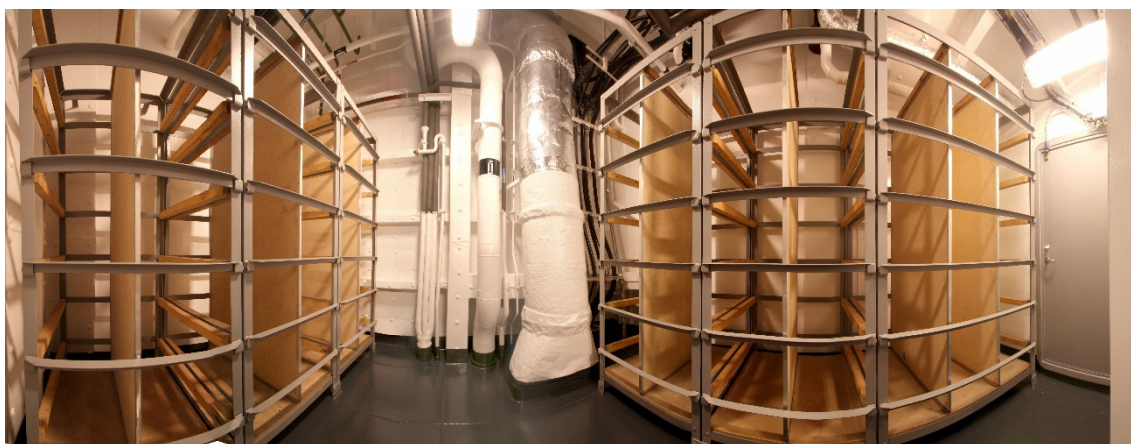
Figura 2: Local de tratamiento de residuos en BPE Juan Carlos I (Fuente: autor)
