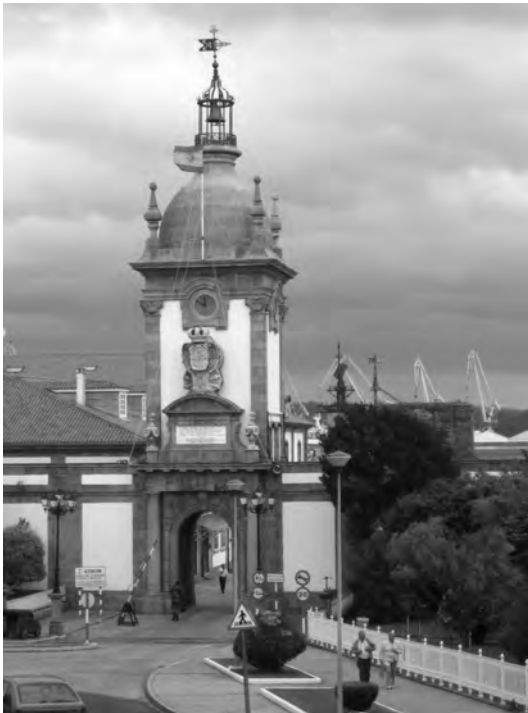
Puerta del Dique del Arsenal de Ferrol. (Foto: M. González).
