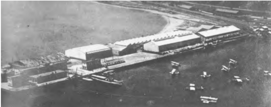
Instalaciones del Contradique
