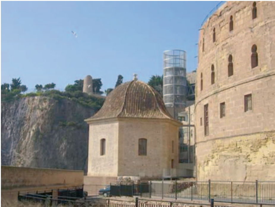
Pabellón de Autopsias de la Armada
