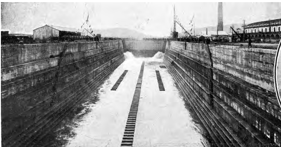
Entrada del agua en el dique por medio de las galerías de inundación.
