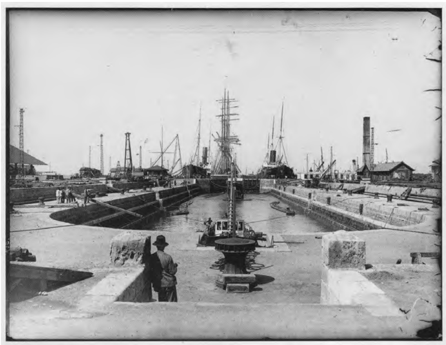
El dique en operación de llenado, desmontando las escoras de dos embarcaciones.
