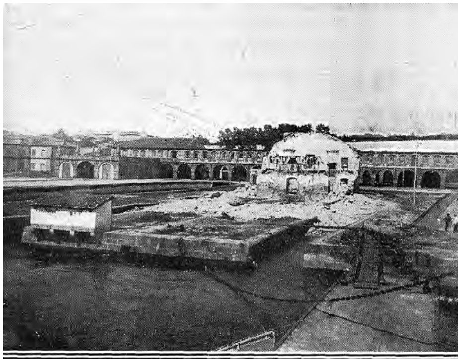
Sitio en donde ha sido construido el dique, antes de empezar las obras.
