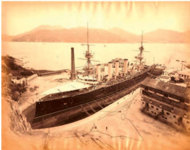
Imagen 6. El crucero protegido de la Royal Navy HMS Powerful durante unas obras de carenado en el dique núm. 1 de la Hong Kong and Whampoa Dock. La foto está realizada a finales del siglo XIX. (FUENTE: Archivo MdR Almirante de Castilla)
