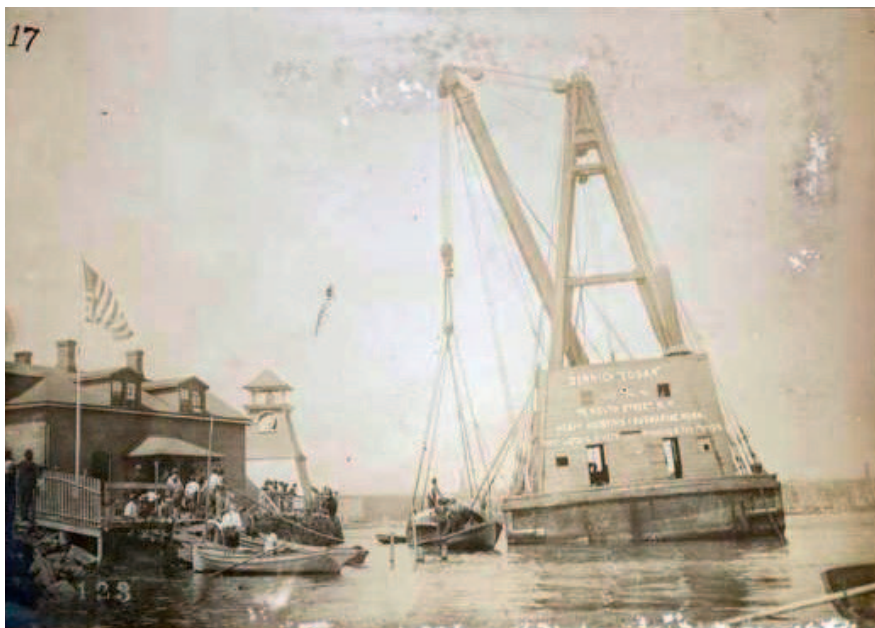
Fig. 7. Levantando el yate Aztec (Merritt-Chapman & Scott Corporation, n.º 2008.28.3.10)
