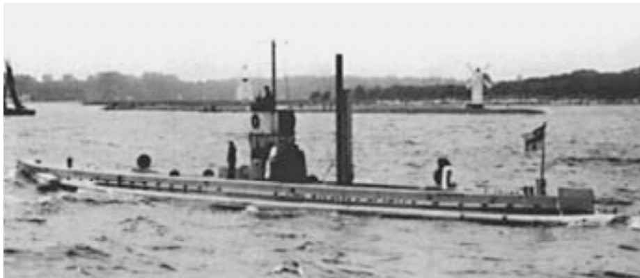
El U-9 , en servicio desde 1910, con 57 metros de eslora, alcanzando 14 nudos en superficie y ocho sumergido, 500 toneladas de desplazamiento, cuatro tubos de torpedo de 450 mm y 29 tripulantes.
