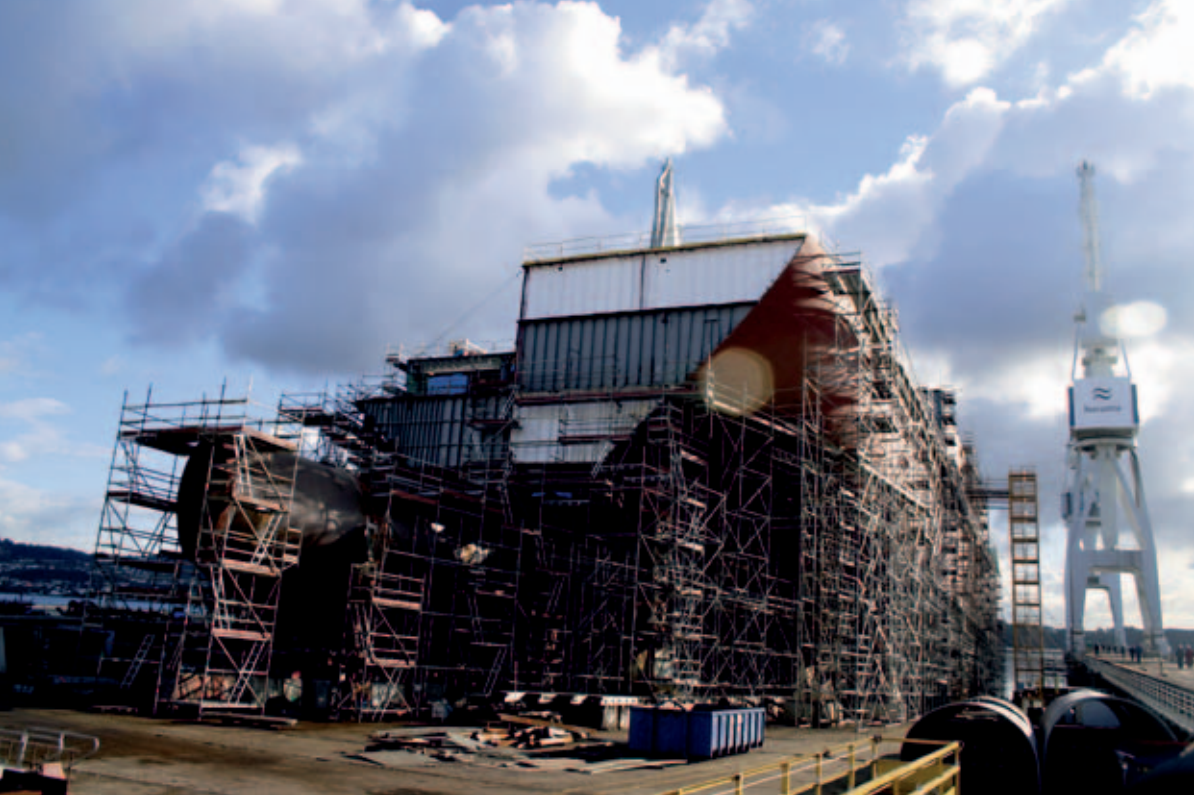
El buque de proyección estratégica Juan Carlos I en avanzado estado de construcción. (Foto: J. Máiz Sanz).
