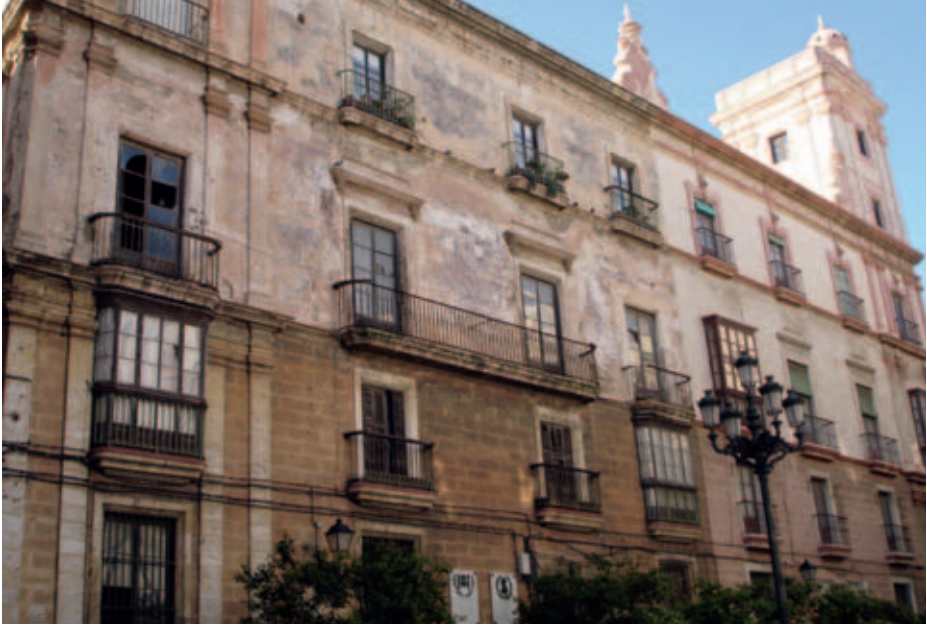
Casa de las Cuatro Torres, en la plaza de Argüelles de Cádiz. (Foto: J. R. Sánchez González).
