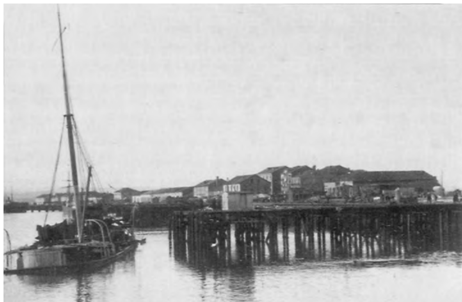
Los restos del Cabo Machichaco tras la primera explosión: tres calles (fuera de la foto y a la derecha) han quedado arrasadas, pero la mitad de popa del buque y el muelle permanecen relativamente intactos. Según planos, en el momento de hacer esta foto en el costado de Er habría una sonda de 8,20 m (la popa es más alterosa por el saltillo), aproximadamente medio metro más que en el momento de la explosión. (Foto: de autor desconocido).
