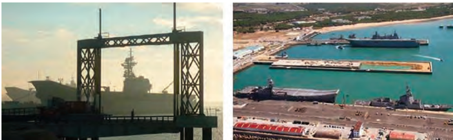
Rampa Ro-Ro en construcción y Base Naval de Rota el 18 de mayo de 2011.
