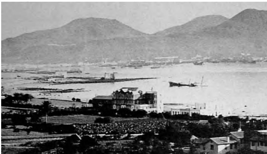
Vista de la zona que actualmente ocupa el Arsenal de Las Palmas.
