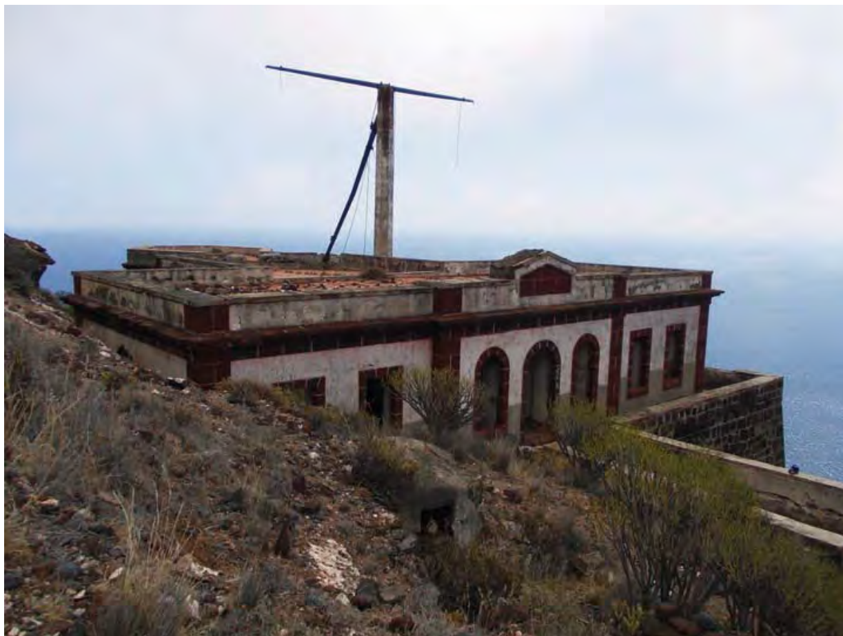
Fachada principal del semáforo de La Atalaya en Tenerife.
