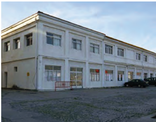
Edificio de Investigación. (Foto facilitada por el autor).
