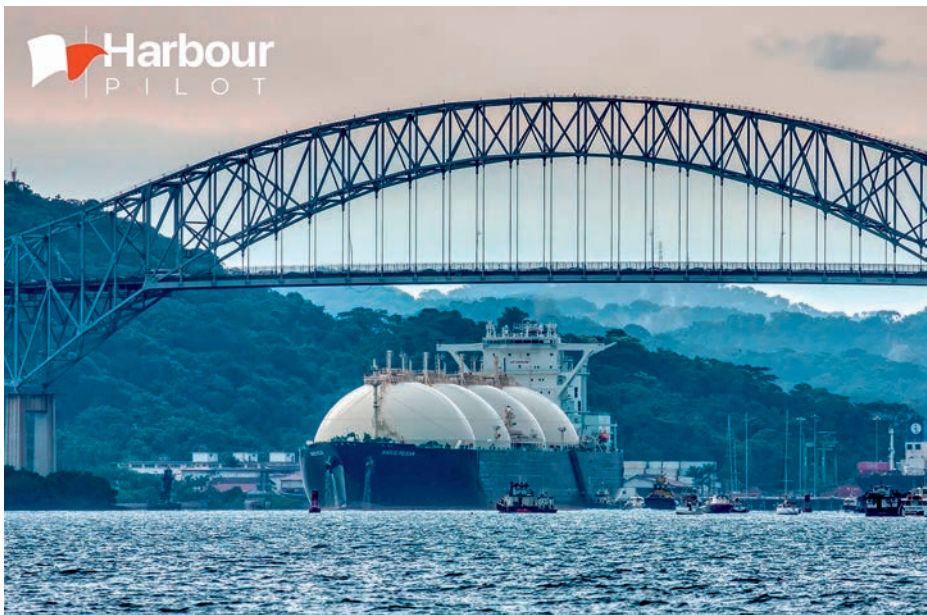
Buque gasero saliendo de puerto. (Fuente: Harbour Pilot )
