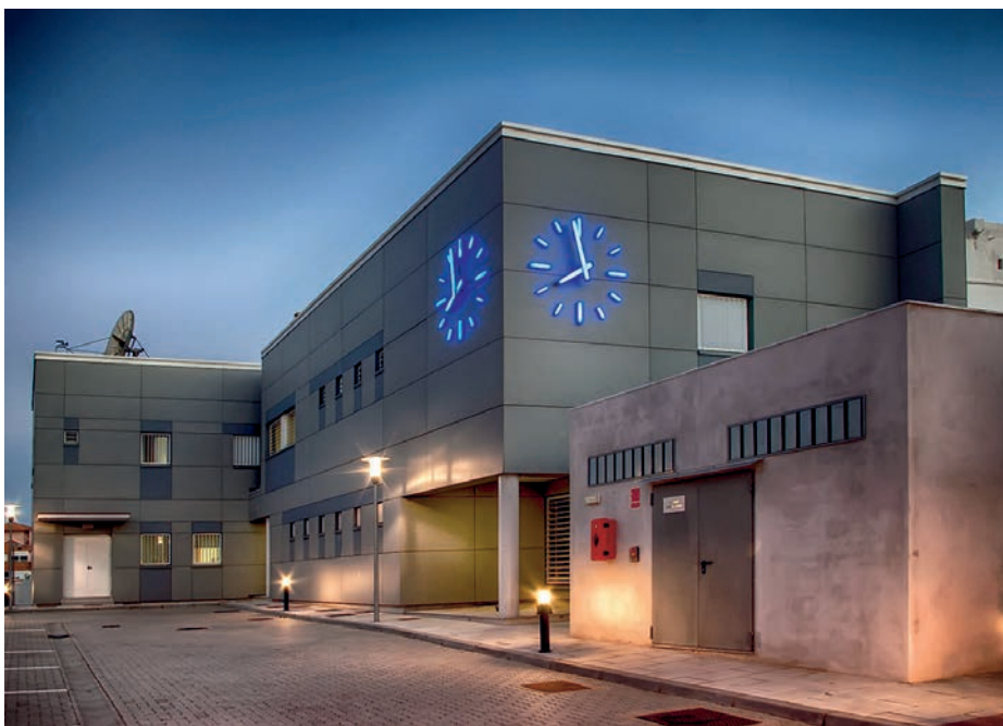
Edificio de la Sección Hora del Real Instituto y Observatorio de la Armada. (Fotografía facilitada por el autor)
