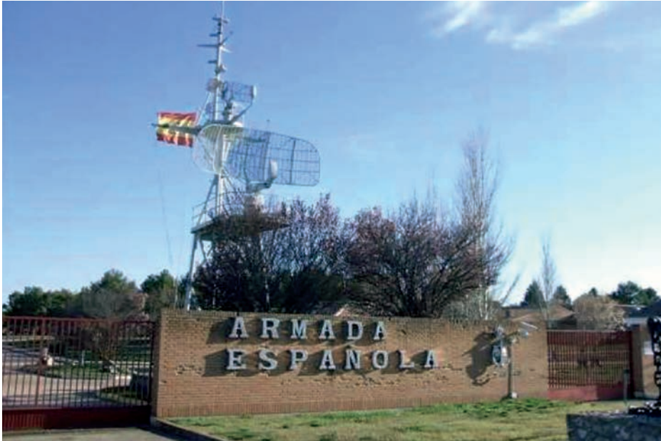
Estación radio transmisora en Santorcaz (Madrid). (Foto: Armada)
