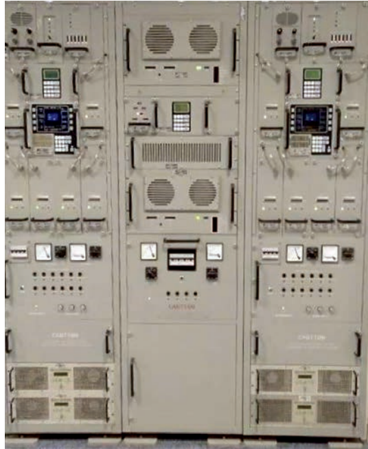
Transmisores Marconi-Elmer de 10 kW de estado sólido. (Foto: Armada)
