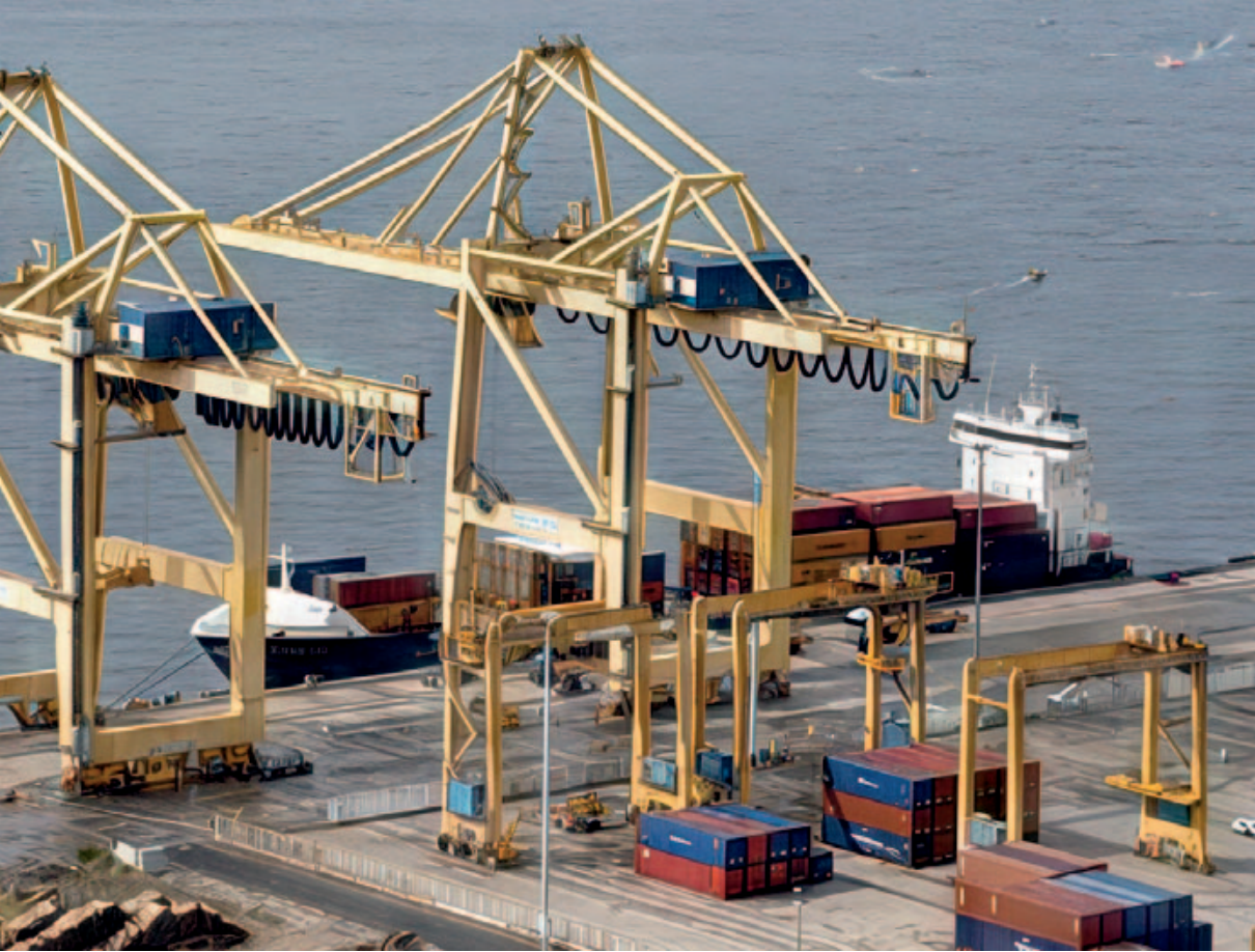
Terminal de contenedores de Ferrol. (Fotografía realizada por el autor)
