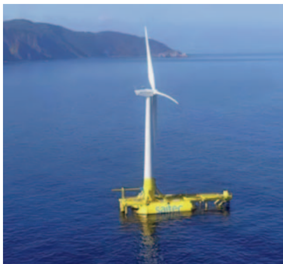
Aerogenerador DemoSATH fondeado frente a la costa de Vizcaya. (Fuente: Saitec Offshore Technologies)
