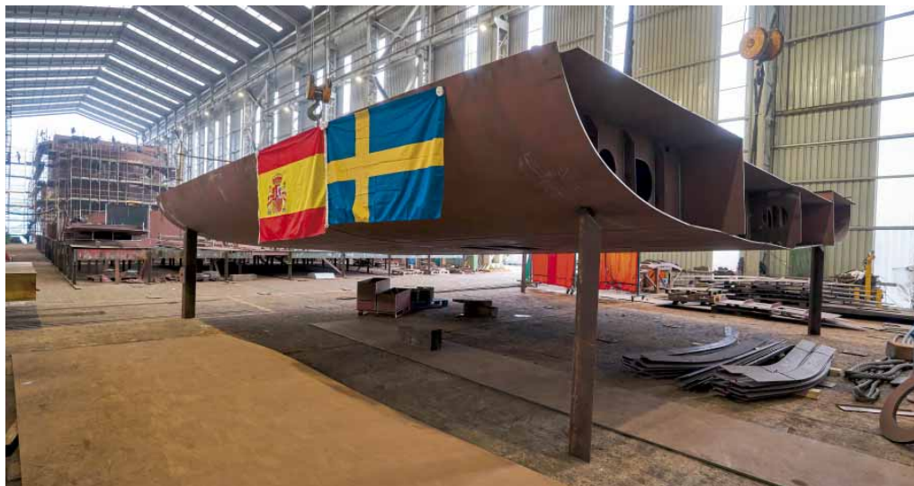
Puesta de quilla. (Fuente: Försvarets materialverk, FMV/Armón)
