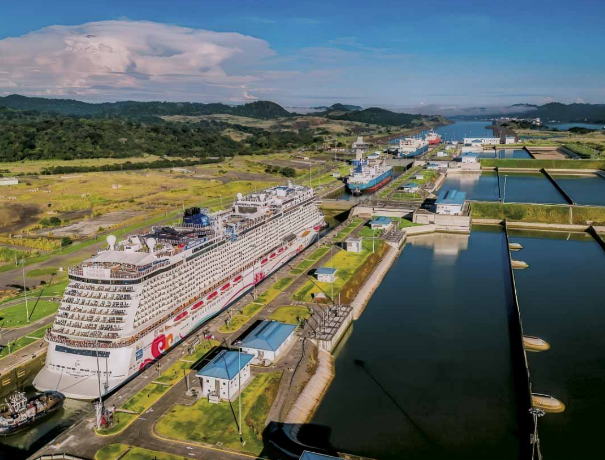
Esclusa de Agua Clara. (Fuente: Autoridad del Canal de Panamá)
