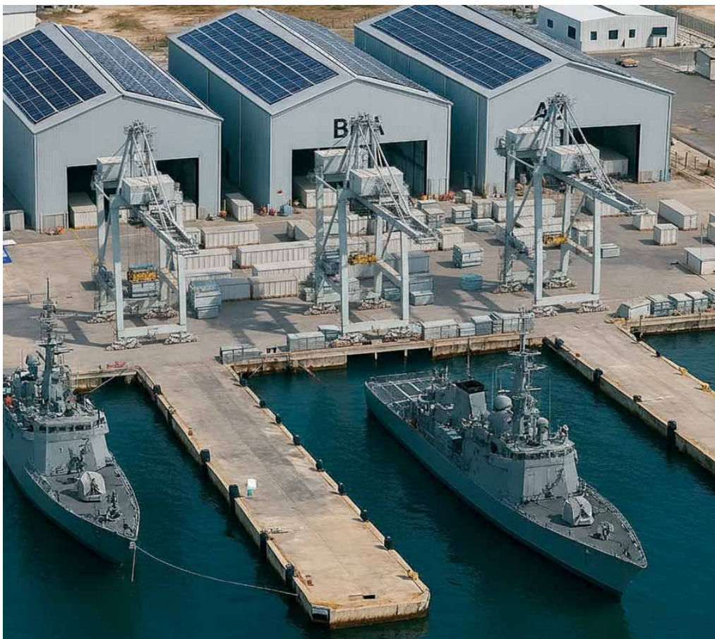
Recreación de la futura base naval de La Algameca. (Fuente abierta generada con IA)
