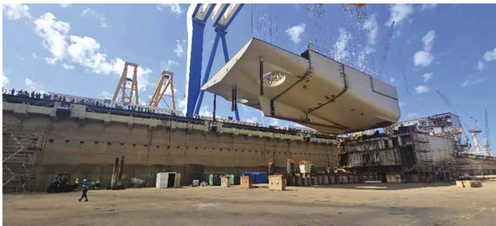
Bajada al dique de la macroestructura 300 del BAM-IS. (Fuente: Navantia)
